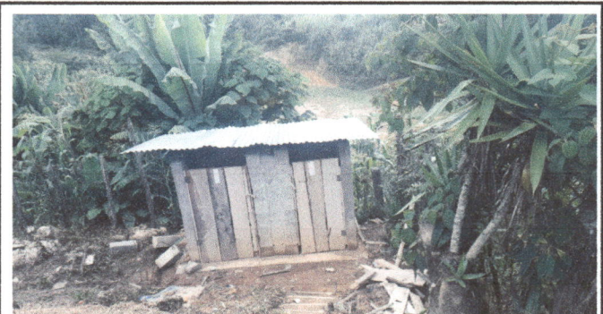
Foto 4: cambio de puerta lamina de la letrina.
