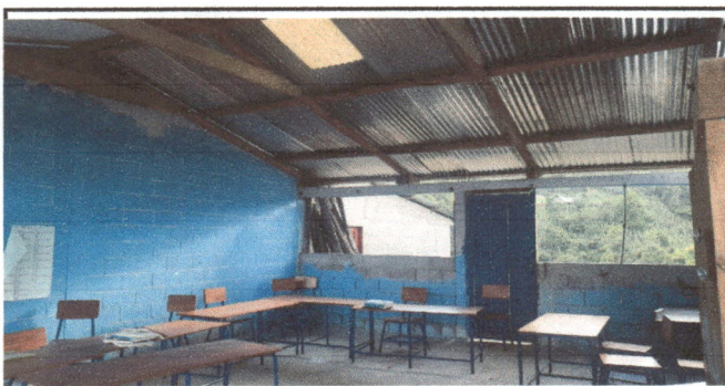
Foto 5: Cambio de lamina a canalada por troquelada.
