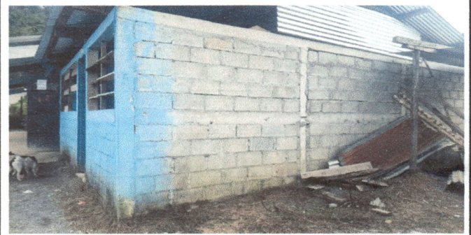
Foto 2: repello de las paredes.
