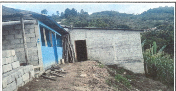
Foto 6: complemento de altura de paredes.
